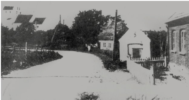
Sprøjtehuset i Ubberud, nedrevet 1958
