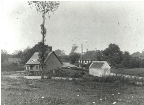
Sprøjtehuset i Korup, nedrevet ca. 1971
