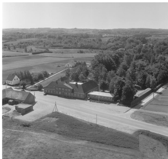
Slukefter Kro på hjørnet af Rugårdsvej og Søbakkevej
