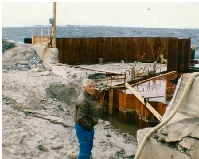
Ove ved havne-byggeriet på Avernakø
